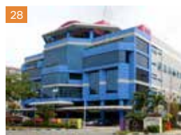
521 Bukit Batok Street 23
